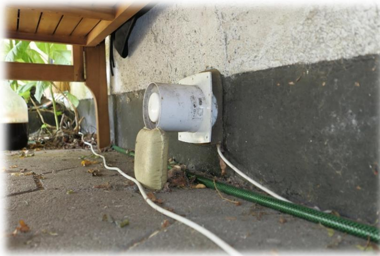
Fig.4. Ventilationshul 2 mod vest, med eksperimentelt, men effektivt radonsug monteret.
